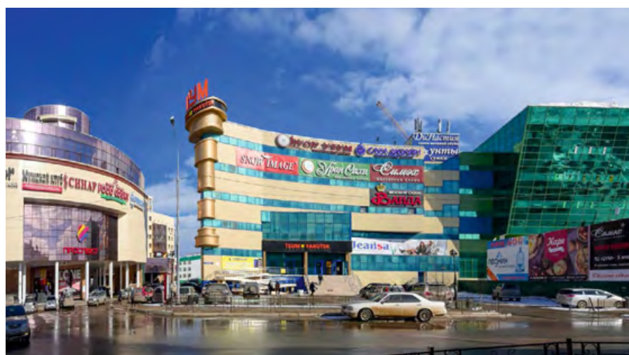
Торговый центр ЦУМ «Якутск» (г. Якутск, ул. Курашова, д. 4)
